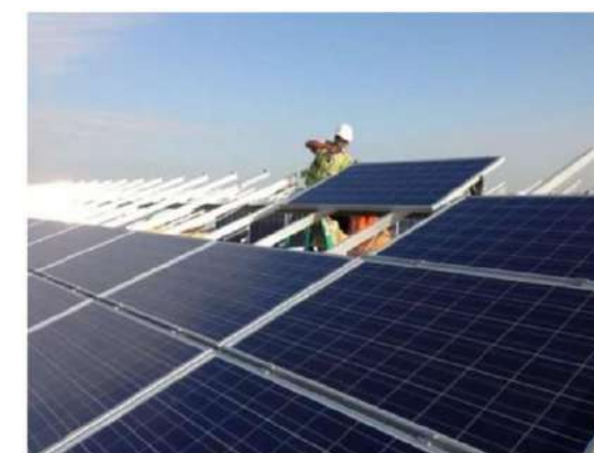
Mise en place d'un module sur une table d'assemblage (Source : Auddicé environnement)
