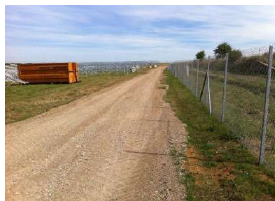
Photo 23 : Exemple d'une bande de roulement adaptée aux véhicules lourds (Source : TSE)
