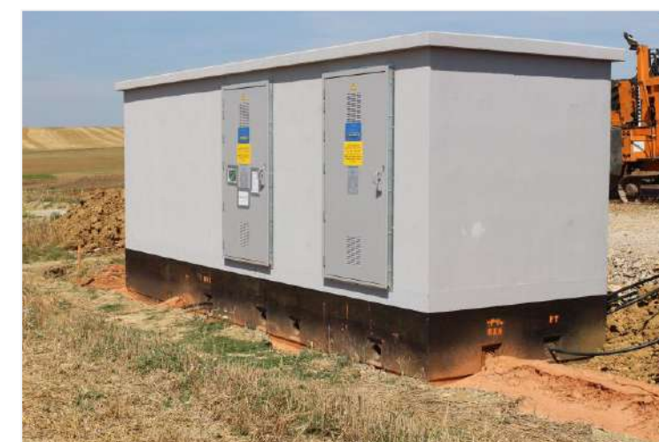
Installation d'un poste livraison (Source : Ora environnement)
