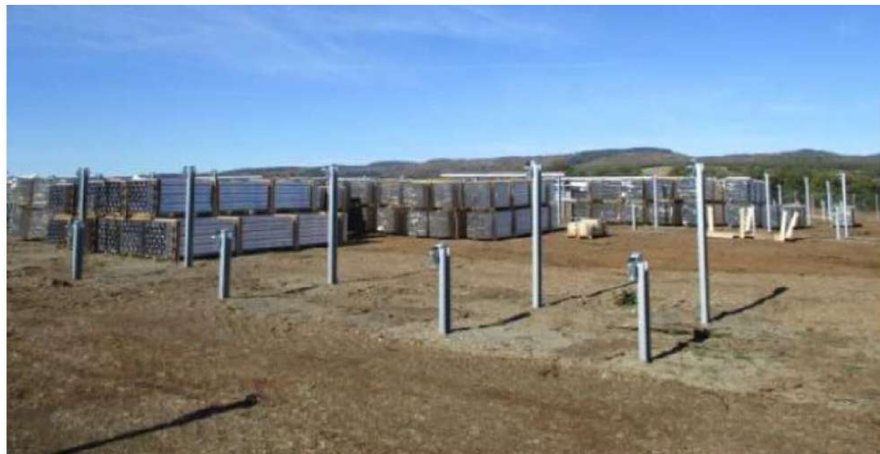
Exemple de pieux battus dans le sol (Source : Auddicé environnement)
